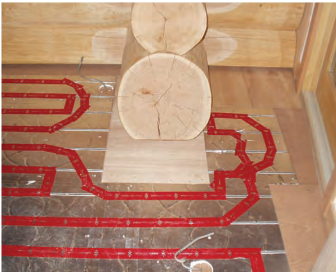
ログハウス柱廻りの変形カット
