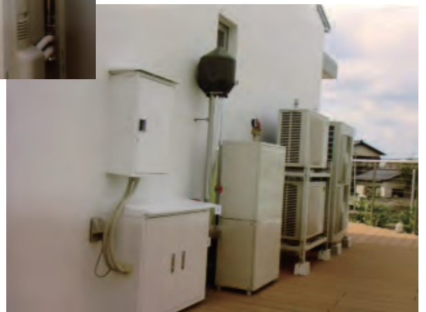
ヒートポンプ床暖房エコメールレオ 施工写真 k 様邸
