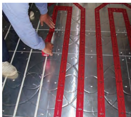
パイプをはめ込んだ後、赤のアルミテープを貼る
