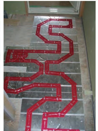
変形パネルの施工例
