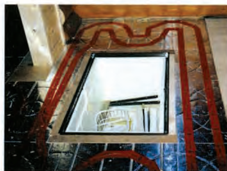
床下収納庫廻りの床暖房施工例
