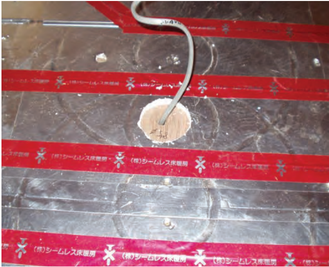
床コンセント用にパネル加工
