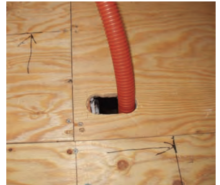
構造合板上へのCD管取出し
