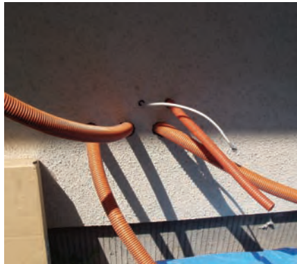
熱源機取付場所へのCD管
