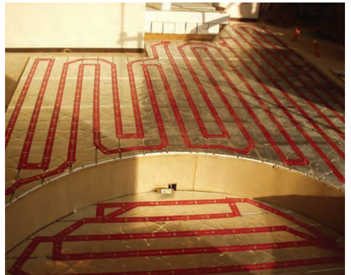
円形カットのパネル貼り
