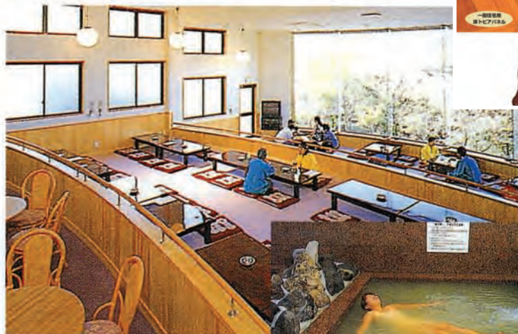
大休憩室 床暖房工事
