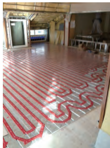
保育園床暖房工事
