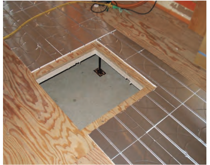
床下収納部分のパネル部分
