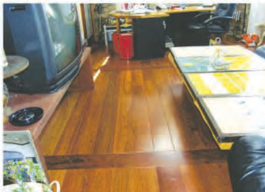
W 邸室内施工
