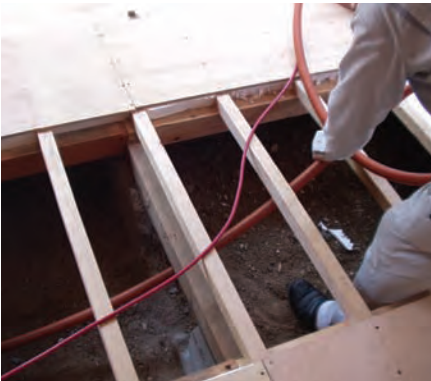
床下へのCD管配管
