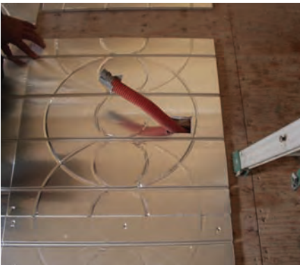
CD管取出口の床暖房パネル仮置
