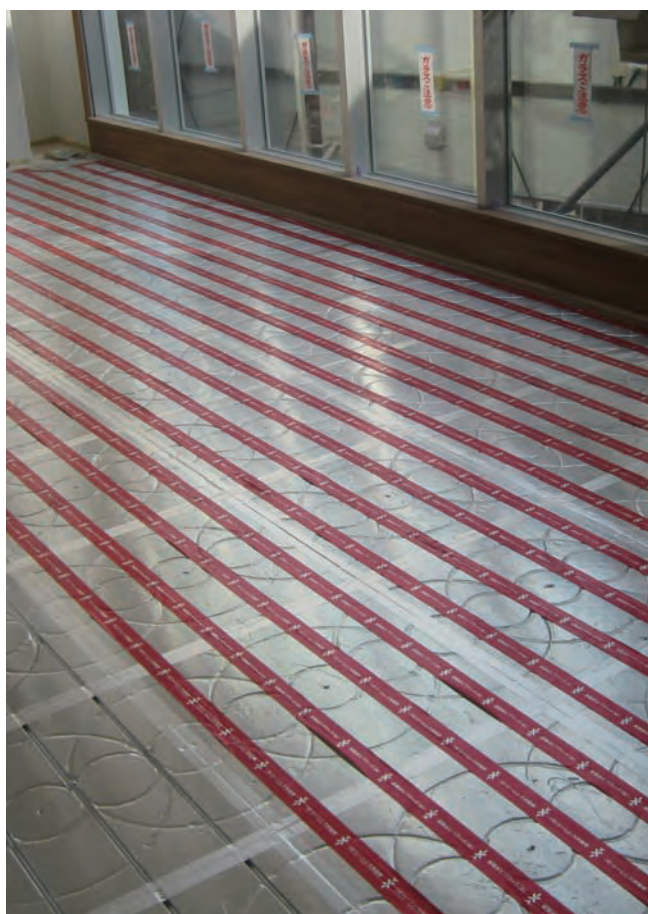
シームレス床暖房パネル施工写真
