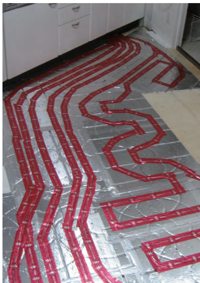
シームレス床暖房パネル施工写真
