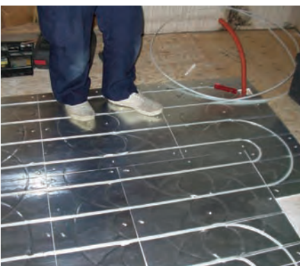
温水パイプを床暖房パネルの溝にはめ込む
