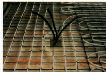
コンクリート埋込み工事途中
