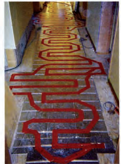
廊下面の施工例
