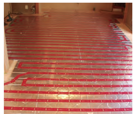
パネル・パイプの敷設が完了
