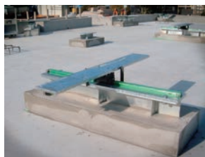
免震装置を設置した基礎「CLB」
