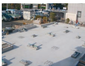
免震装置を設置した基礎(全景)
