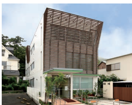
神奈川県 | 鉄筋コンクリート造 3階建 | 建築面積 54.6坪
