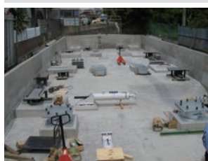
質量1000tとなる鉄筋コンクリート造にエレベーターの付いた重厚なクリニック兼住宅 (P.6 設計例②参照)
