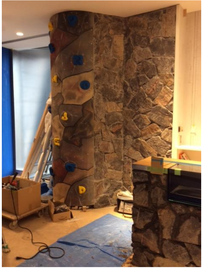
1. ボルダリングジム (山口県) 2. 教育施設 (広島県)
