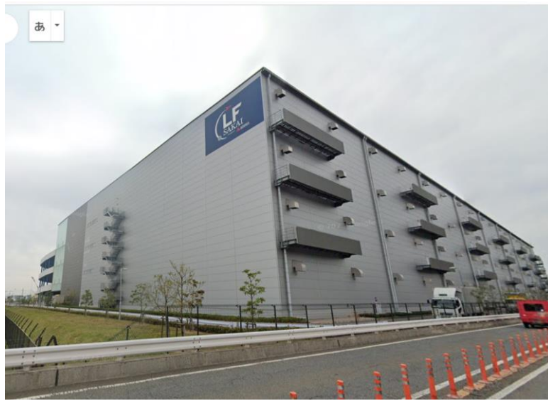
(仮称) 堺物流センター
