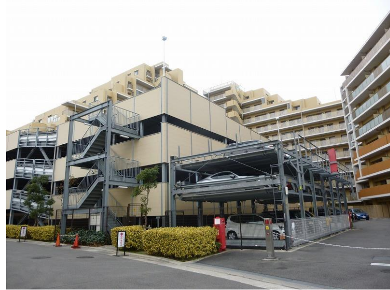
パークシティ梅が丘プラムヒルズ工事
