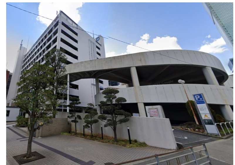
近鉄パーキングビル駐車場棟改修工事
