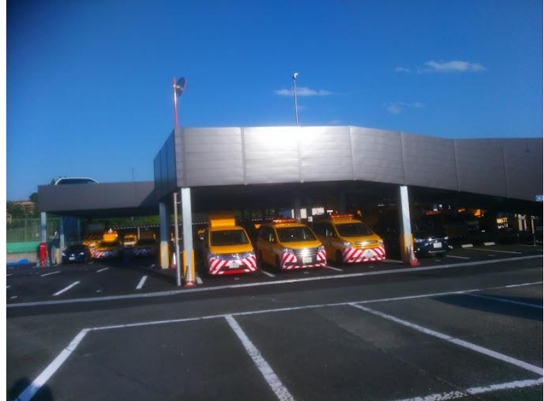
名神高速道路大阪高速道路事務所
