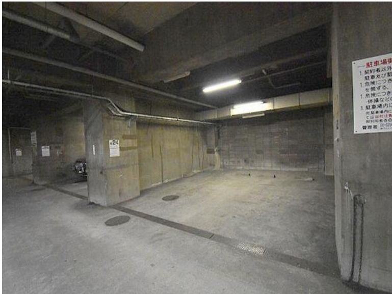
サチンマンション第7新大阪大規模修繕工事
