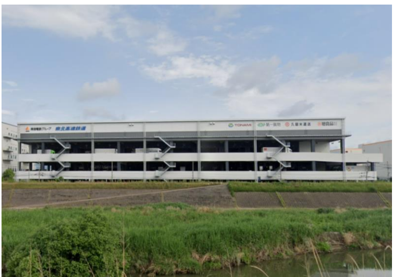
北大阪トラックターミナル新1号棟
