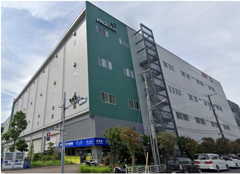
新木場1丁目Project(車庫棟)
