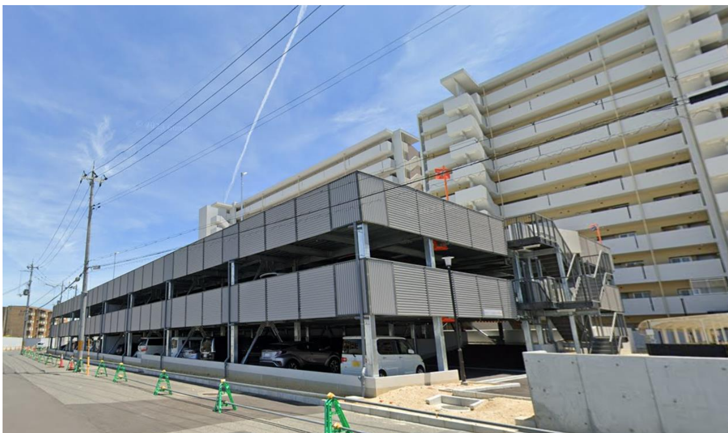
(京都府) 物件名：大阪府営堺三原台 第2期高層住宅 新築工事 施工部位：第1・2・3・4工区 自走式駐車場
