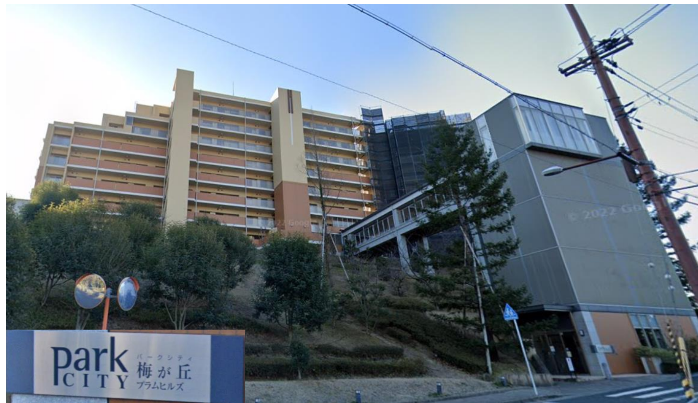
(大阪府) 物件名：パークシティ 梅が丘プラムヒルズ 改修工事 施工部位：自走式駐車場R階
