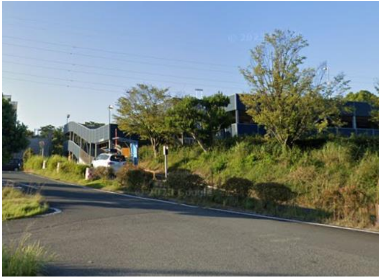
九州自動車道 八幡IC管理施設
