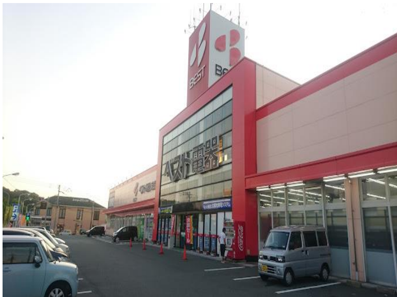
ベスト電器志免店屋上駐車場工事
