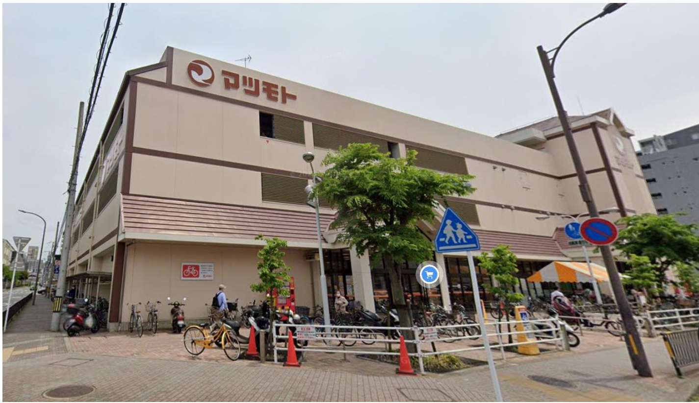
(京都府) 物件名：ベルタウン丹波口駅前店 改修工事 施工部位：自走式駐車場R階 自走式駐車場3階一部 機械基礎廻り
