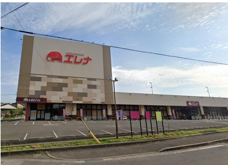
エレナ久原店増築工事
