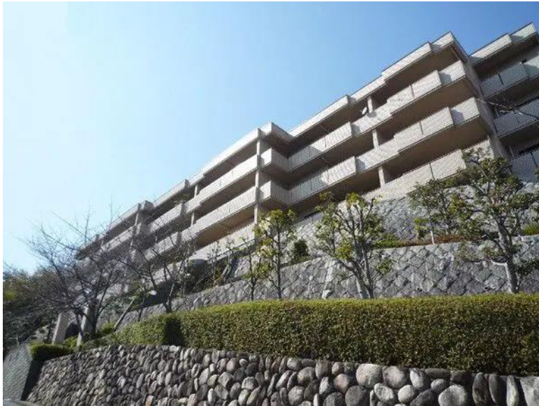
ロイヤルアーク逆瀬川大規模修繕工事
