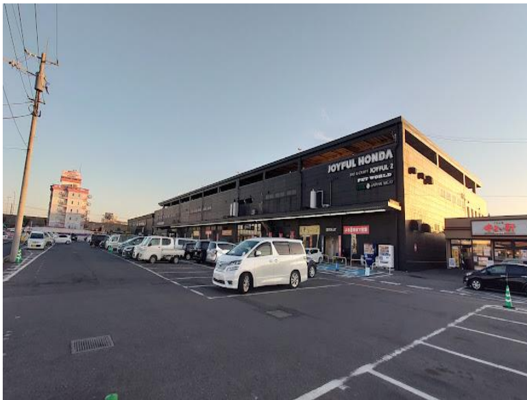
ジョイフル本田 富里店 新築工事
