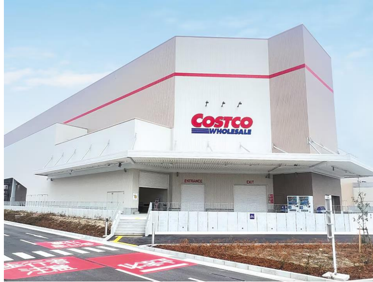
コストコホールセール門真倉庫新築工事
