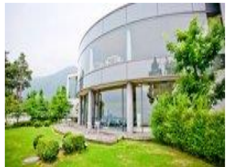
湖邸滋びわこクラブ宿泊棟大規模修繕工事
