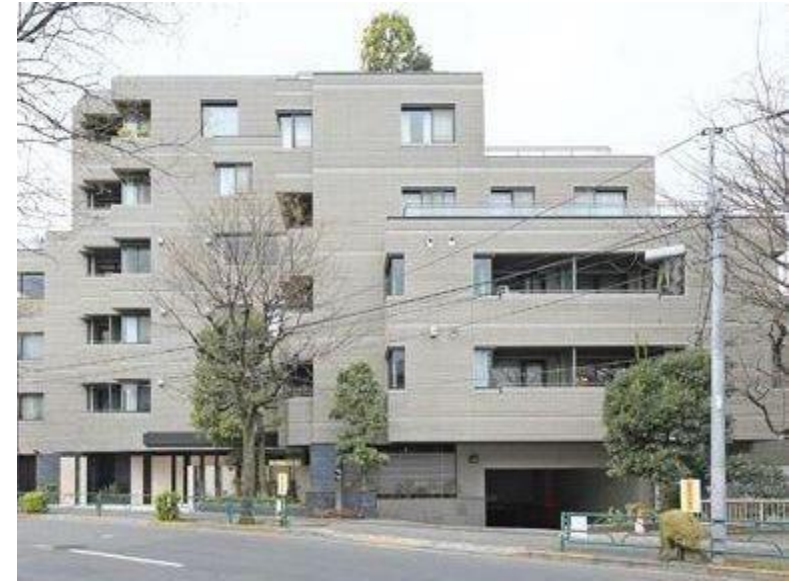
南青山豊田パークマンション大規模修繕工事
