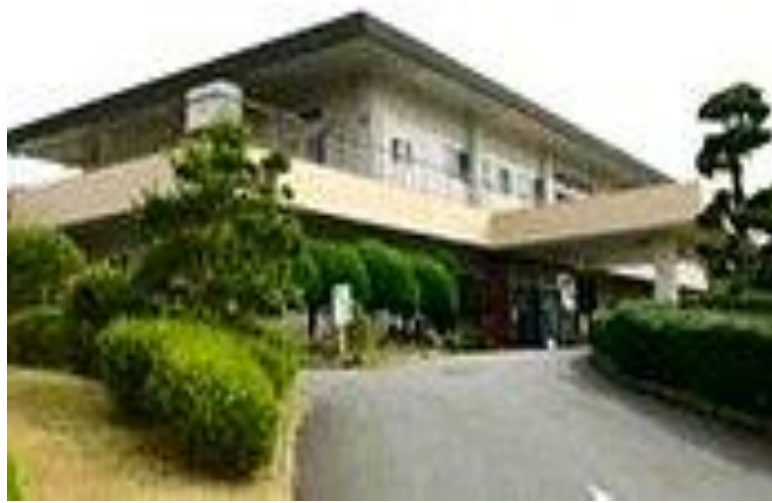
かほゴルフクラブクラブハウス防水工事
