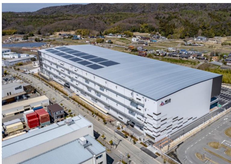
神戸テクノ・ロジスティクスパーク物流倉庫
