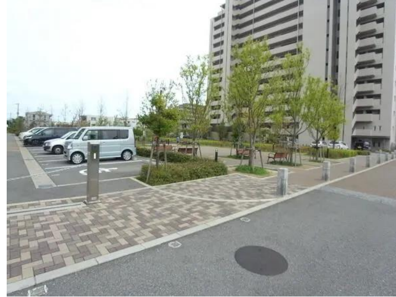
イニシア塚口自走式駐車場
