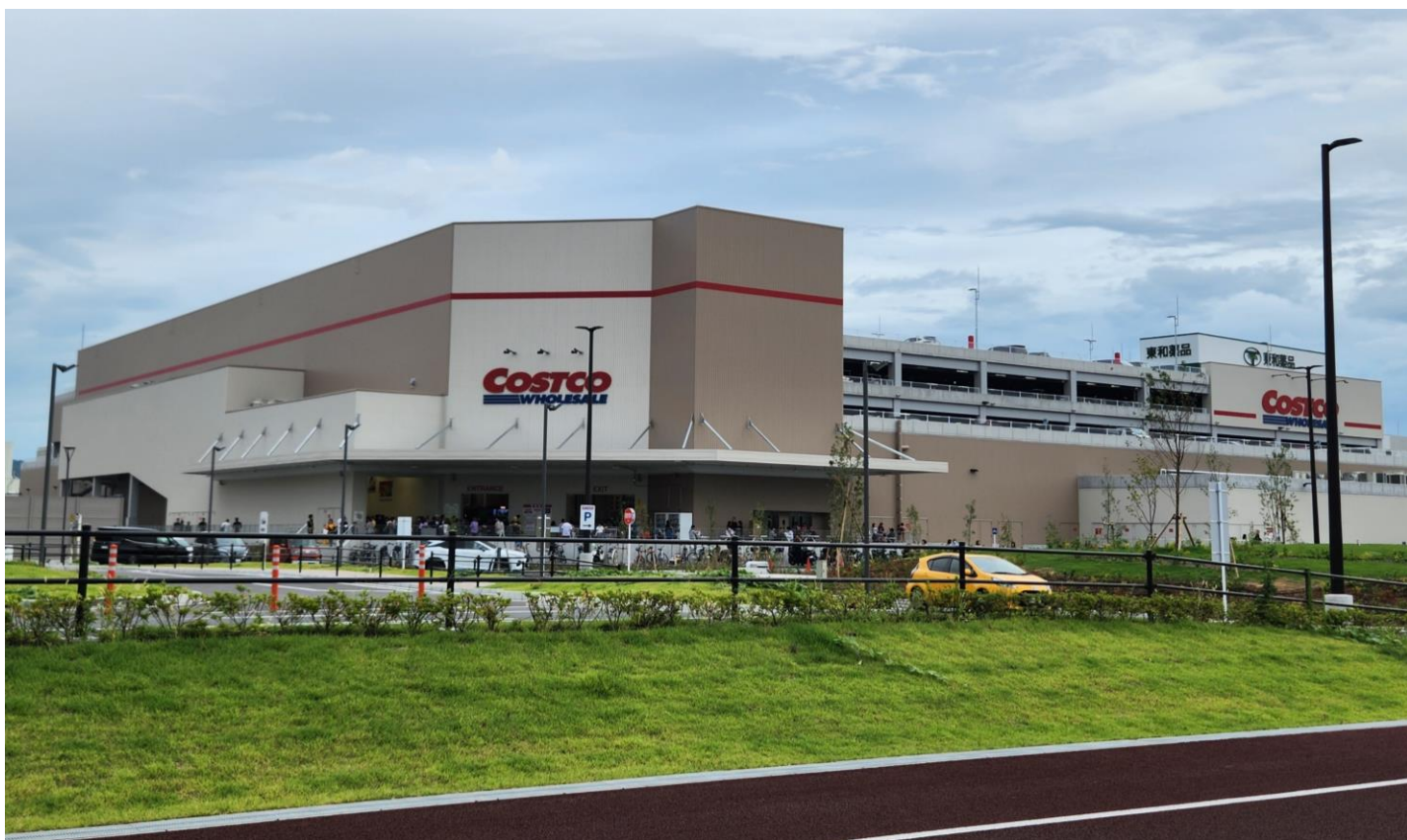
(大阪府) 物件名：コストコホールセール 門真倉庫 新築工事 施工部位：自走式駐車場R階 自走式駐車場3階一部 スロープ
