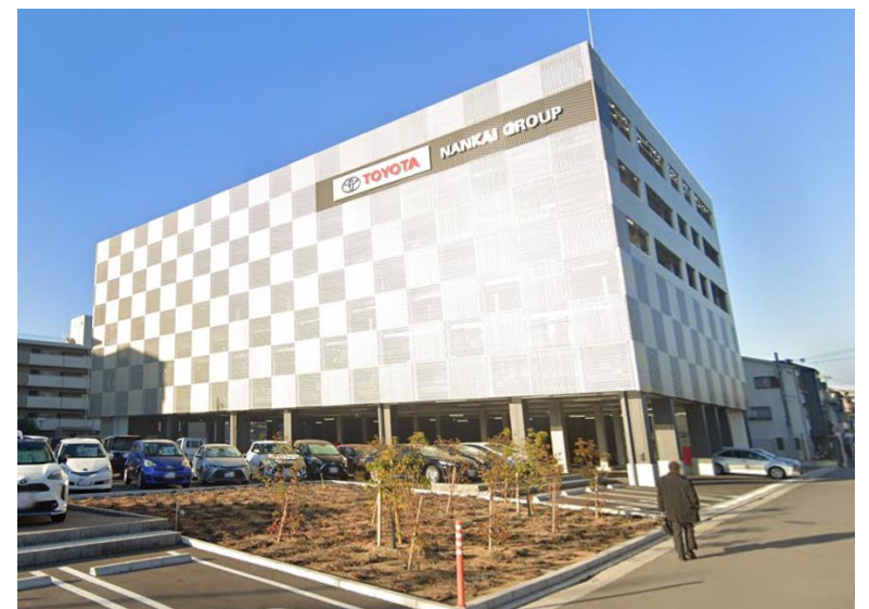
トヨタカローラ南海本社駐車場
