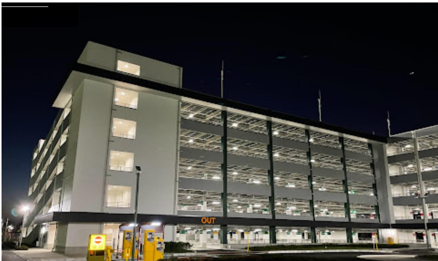
(岡山県) 物件名：岡山県西部総合公園 立体駐車場 新築工事 施工部位：自走式駐車場中層階
