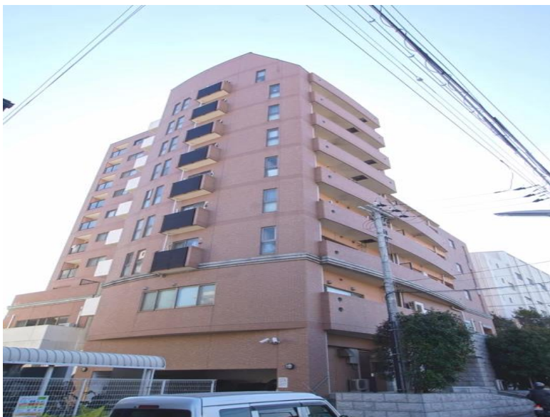
アーバンビュー星陵台大規模修繕工事
