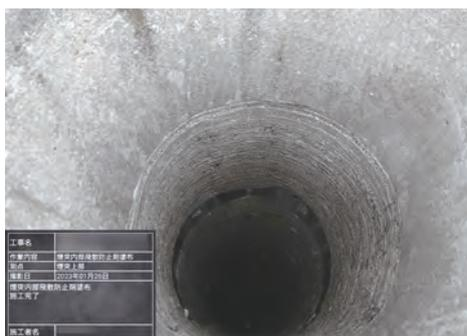
マルホウが得意とする超高压水を利用した煙突断熱材除去工事を行います。
