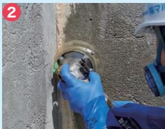
アタッチメントを変えて入隅部も施工【P16 特許証(塗材剥離装置)】
