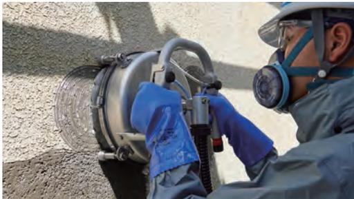
**【使用用途】** 建築用石綿含有仕上げ塗材、薄塗材C(セメントリシン)、薄塗材E(樹脂リシン)、可とう形外装薄塗材E(弾性リシン)防水形外装薄塗材E(単層弾性)、複層塗材E(アクリル系吹付けタイル)、複層塗材RE(水系エポキシタイル)、防水形複層塗材E(複層弾性)、複層塗材C(セメント系吹付けタイル)、厚塗材C(セメントスタッコ)、厚塗材E(樹脂スタッコ)、建築用下地調整塗材、下地調整塗材C(セメント系フィラー)、下地調整塗材E(樹脂系フィラー)
